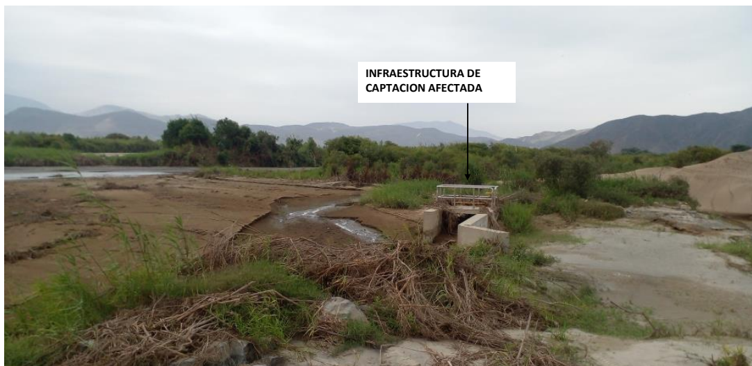
FIGURA N°03: EN LA TEMPORADA DE MAXIMAS AVENIDAS, EL RÍO SAMANCO (RIO NEPEÑA), SE DESBORDA EN ESTE TRAMO DEL SECTOR HUAMBACHO EL ARENAL Y HUAMBACHO LA HUACA, AFECTANDO LA INFRAESTRUCTURA DE CAPTACION.
